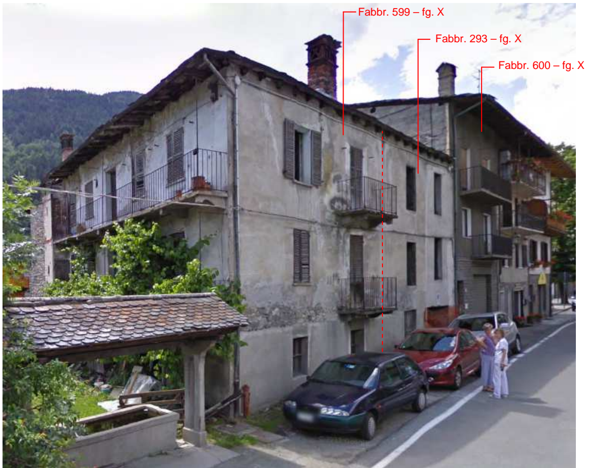
foto 8.1 (fabbricati 599 – 293 – 600 – fg. X)
