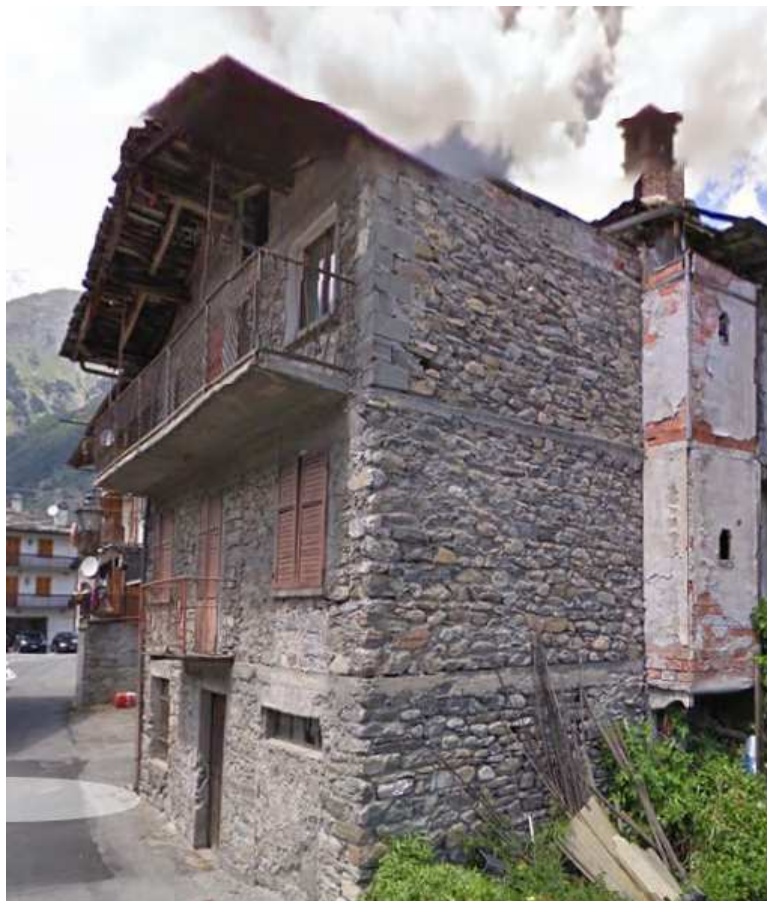
foto 8.3 (fabbricato 267 – fg. X)
